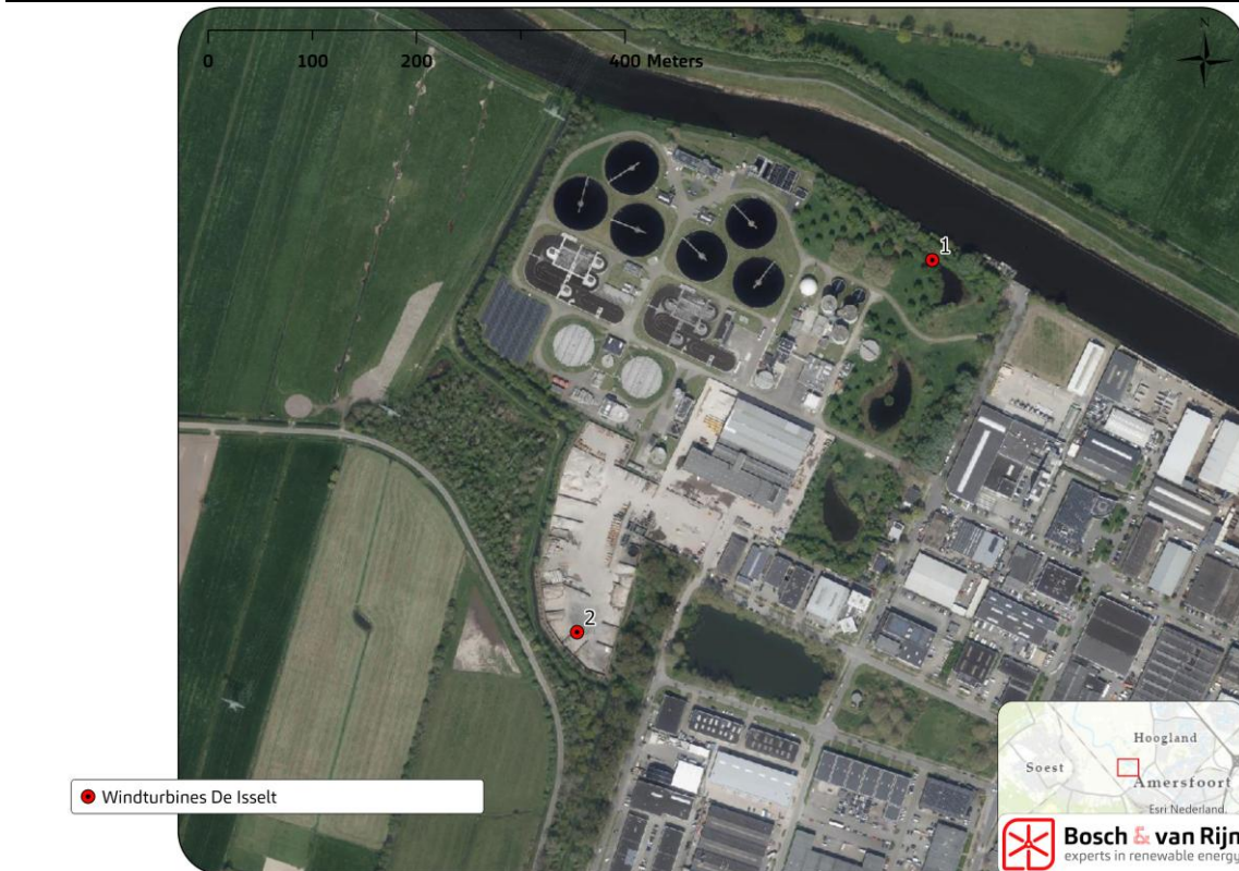
Figuur 1 Luchtfoto uit 2023 met de windturbineposities.
